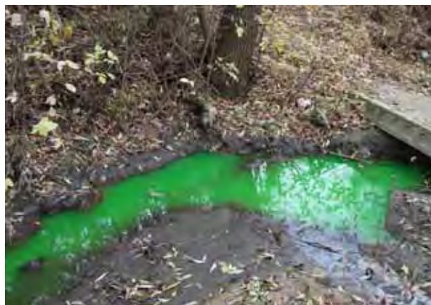
Фото 1. Выход окрашенной сетевой воды в ручей при утечке из трубопровода
