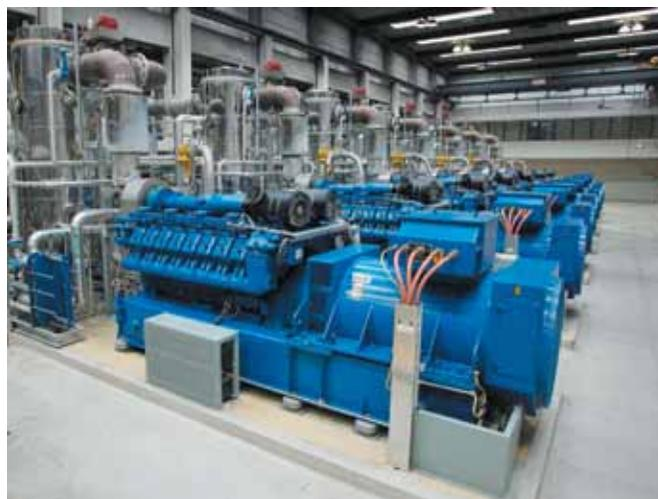
Рис. 3. Когенерационные установки для инсталляции в здании
