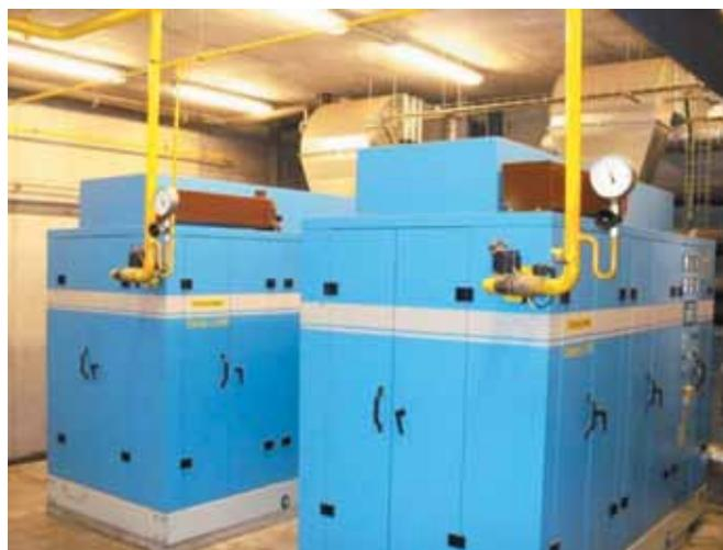
Рис. 2. Когенерационная установка в модульном исполнении
